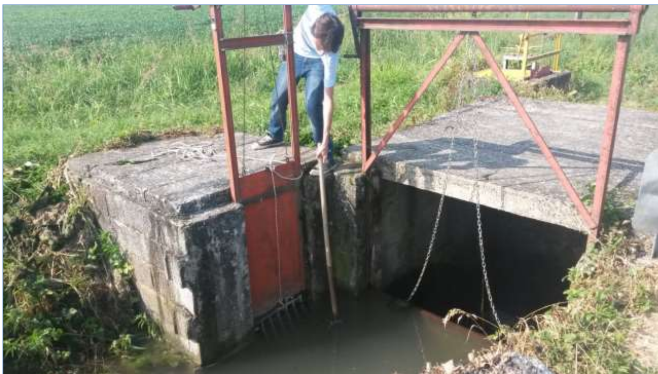
Opera di captazione terminale delle acque del depuratore di Fiorenzuola nel canale Mulino di Fiorenzuola d'Arda per essere immesse nella tubazione dello Sgarzone, località Prato Grande di Baselicadue (Foto 3)
