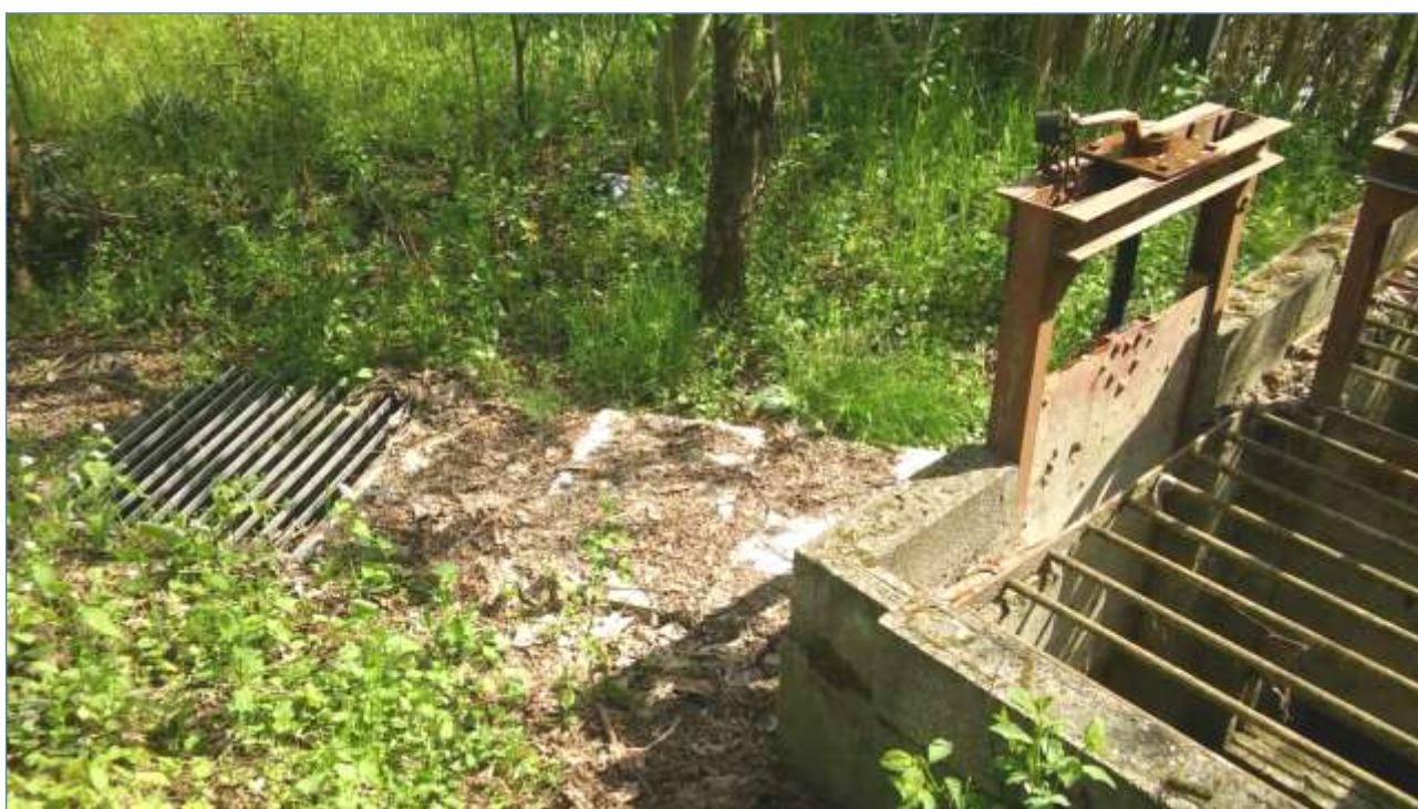
Derivazione dell'attuale tubazione San Rocco Pallavicino con la tubazione Lungo Arda e con la tubazione San Rocco Grilli nel quartiere Madonna d'Arda a Fiorenzuola d'Arda (Foto 18, M2-8)
