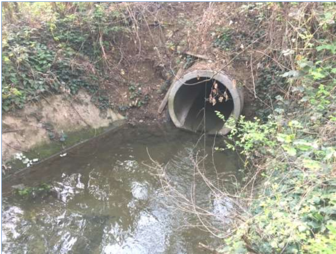
Tubazione Dn 1000 canale della Sforzesca a valle di Castell'Arquato (Foto 2, monte M1-1)
